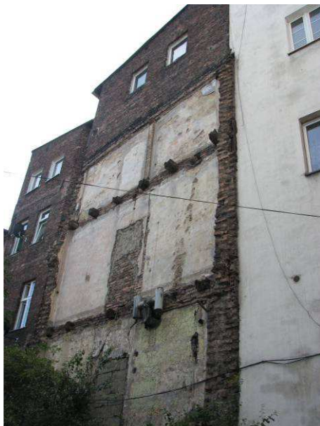
Fot. 1 – widok ogólny na ścianę
