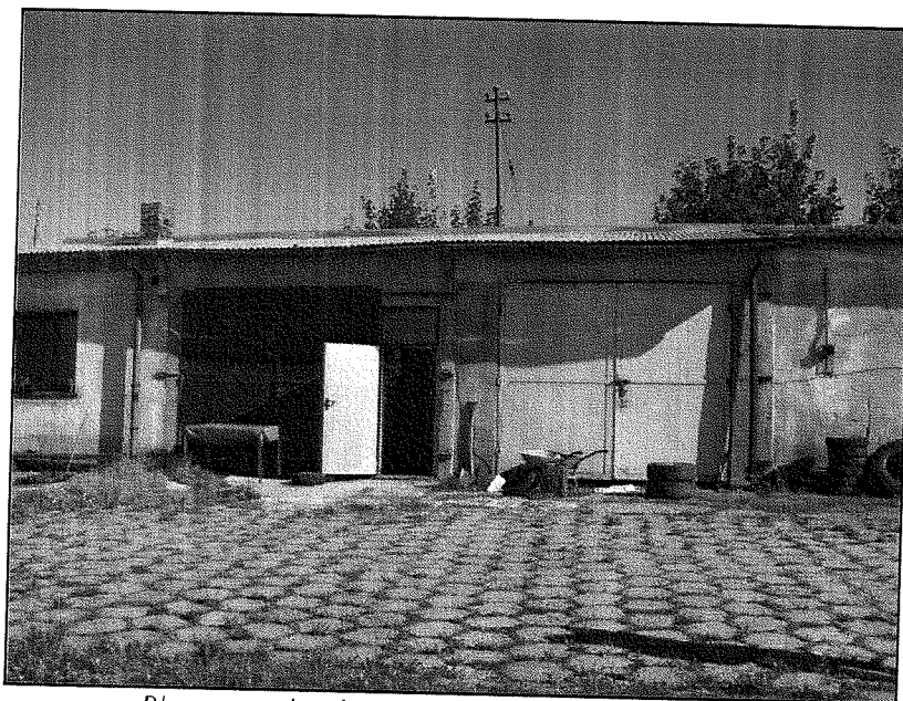
Planowany do adaptacji obiekt – część magazynowa.
